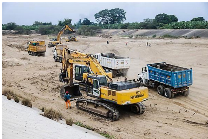
Figura 10. Trabalhos de limpeza do canal do rio na região norte do Peru
