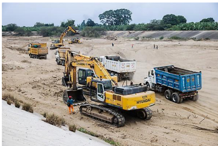
Figura 10. Trabajos de descolmatación del cauce de ríos en la zona norte del Perú.
